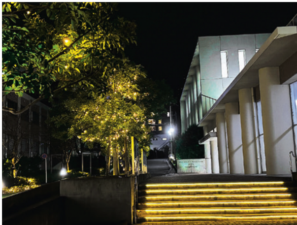
図4 3号棟前 公共道路沿いの点灯 (2024年10月)
