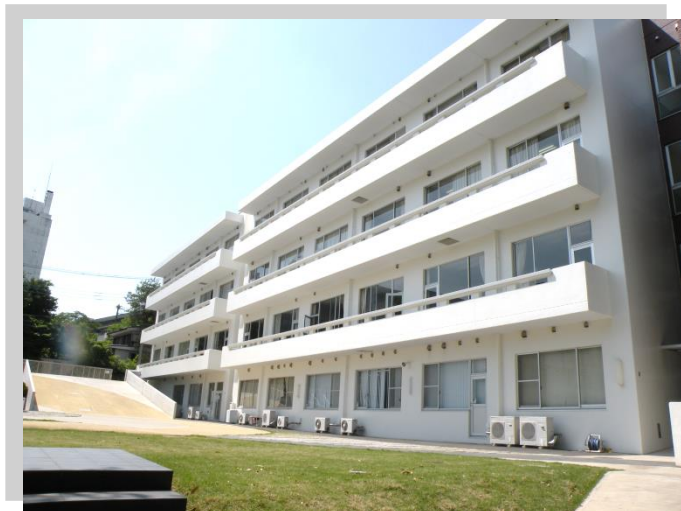
(3) 綺麗に塗装された1号棟壁面と屋上
