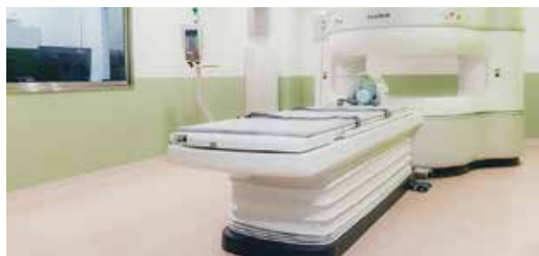
◇設置場所 1号棟・磁気共鳴画像実験室
